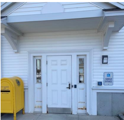
Accessible rear door
